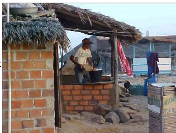
Figura ORL 03. Praia – Pedra do Sal, quiosques montados sem infra-estrutura de saneamento básico.
